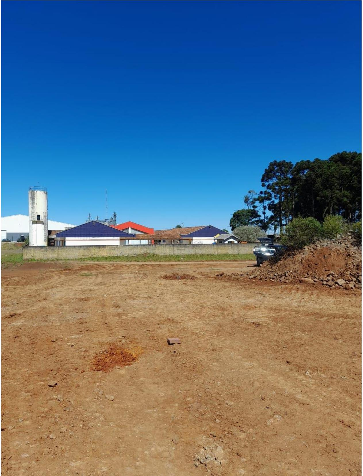
**Imagem 02** – Mostra o corte no terreno com remoção da camada superficial.
