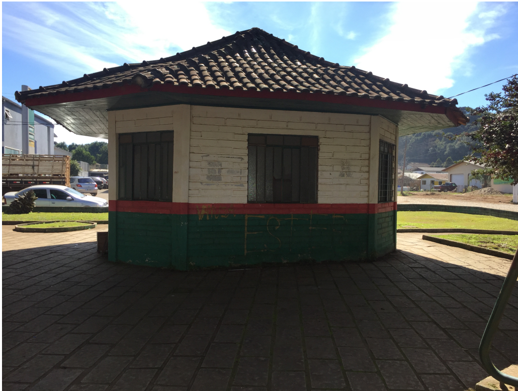
Vista da Edificação com Sanitários Públicos
