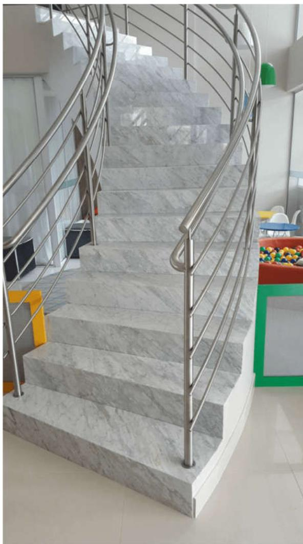
Os mesmos deverão ser em aço galvanizado, e estão inclusos em seus custos, o fornecimento e instalação, completo, até a sua fase final de acabamento, incluindo acabamento cromado brilhoso. O guarda-corpo de aço galvanizado deve ter altura de 1,10 m, montantes tubulares de 1.1/4", espaçados no máximo em 1,20 m, travessa superior de 1.1/2", e tubos horizontais de 1", espaçados com uma distância máxima de 15 cm.
